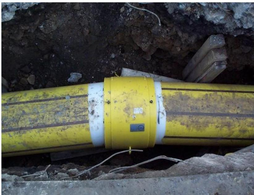
*Пример: Данный стык не был закреплён в позиционере и перед сваркой трубы вышли из муфты*
