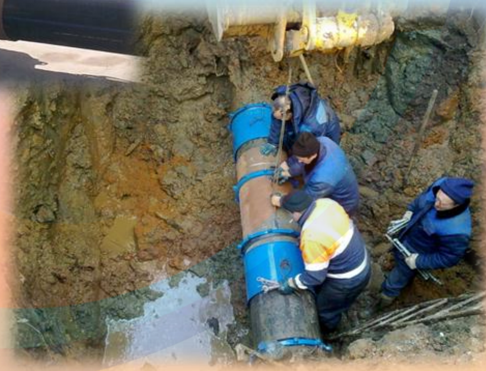
Монтаж и ремонт без сварки
