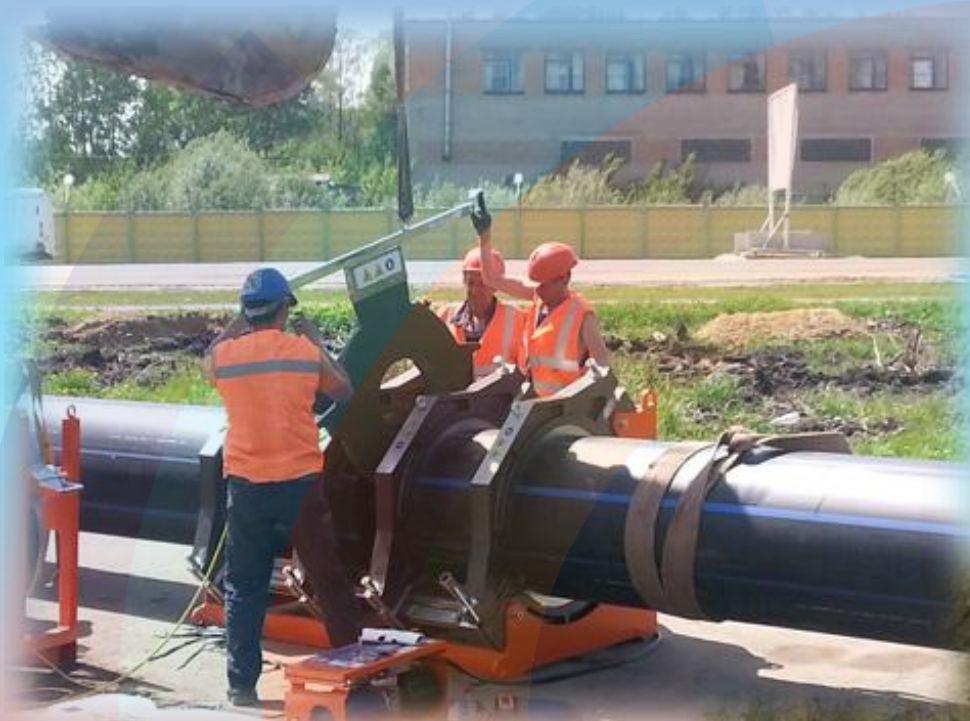
Сварка ПНД труб
